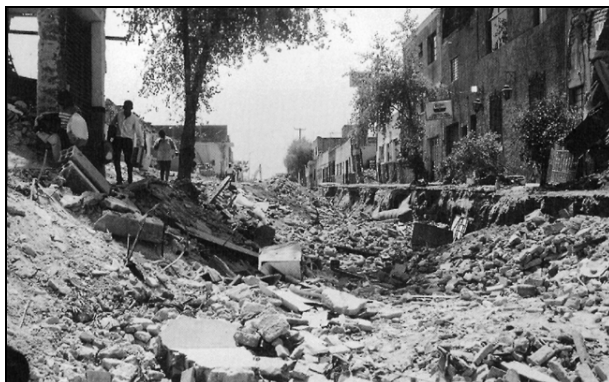
Fig. 33. Stradă din Guadalajara distrusă de explozia din 1992
