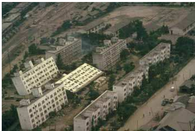
Fig. 3. Clădiri distruse de lichefierea solului în urma cutremurului de la Niigata, 1964 ( www.ce.washington.edu )
