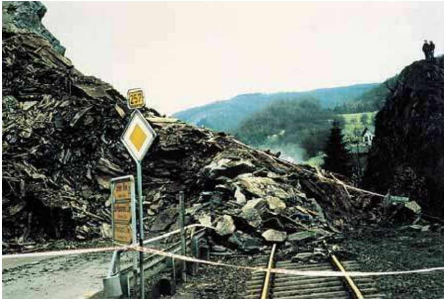
Fig. 15. Prăbușiri de roci care afectează căile de comunicații
